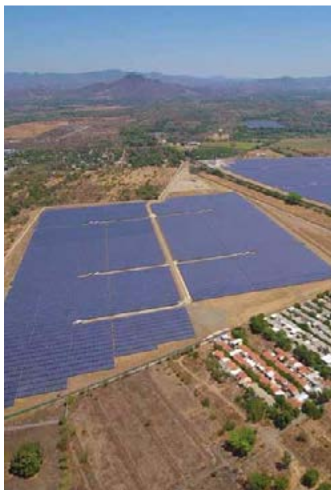
Visita técnica a la planta fotovoltaica Providencia Solar, Rosario de la Paz
