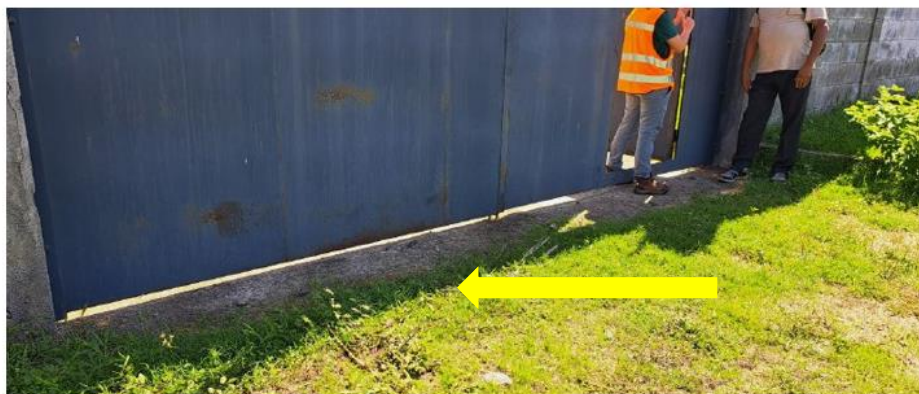
Figura 25. Posible punto de ingreso de reptiles y anfibios hacia el interior de la subestación. Un garrobo adulto que se encontró dentro es probable que ingresara por este sitio.
