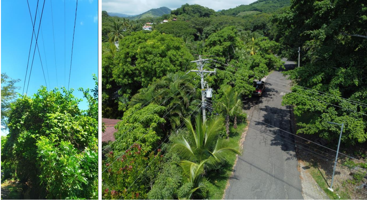
Figura 29. Fotografías que muestran la poda que evita el contacto directo con las redes primarias, pero deja el contacto con las redes secundarias.
